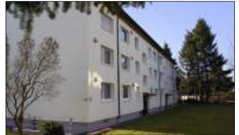
Das Mehrfamilienhaus nach der Komplettanierung.
