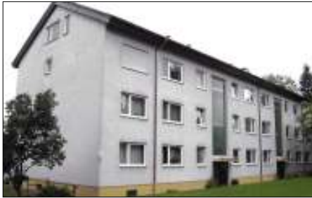
Ein Bild aus vergangenen Tagen: Dieses 12-Familien-Wohnhaus in der Wiesenstraße wurde in drei Bauabschnitten komplett saniert.
